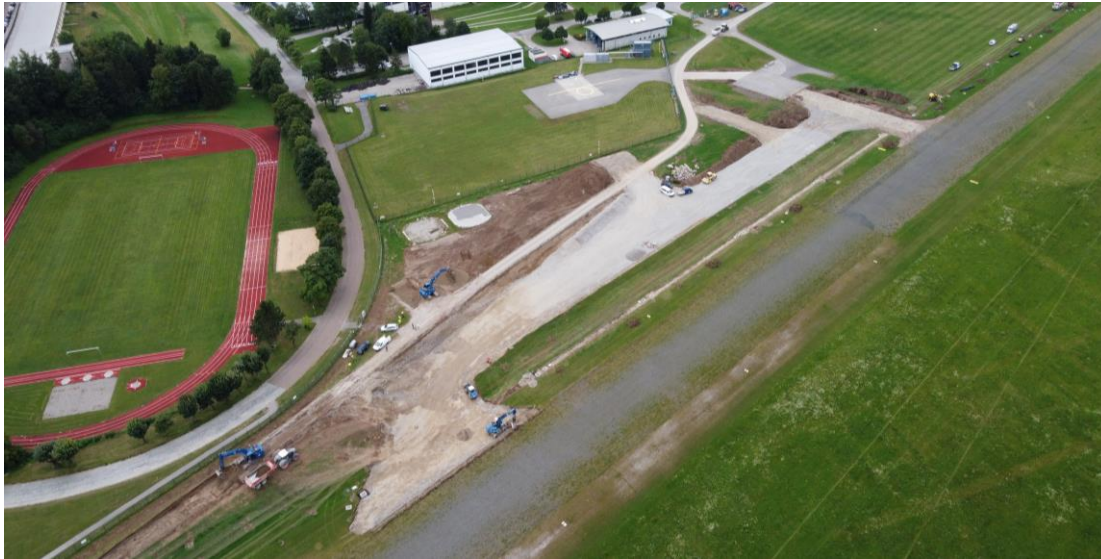
Infrastrukturelle Anpassungen am Sprunggelände Altenstadt / Heeresflugplatz Altenstadt
