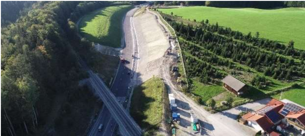
Böschungssanierung an der B472 - Umfahrung Hohenpeißenberg (2000)
