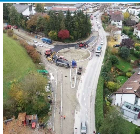
Ausbau Ortsdurchfahrt Tutzing
