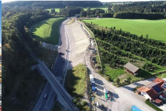
Böschungssanierung an der B472 - Umfahrung Hohenpeißenberg (2000)
