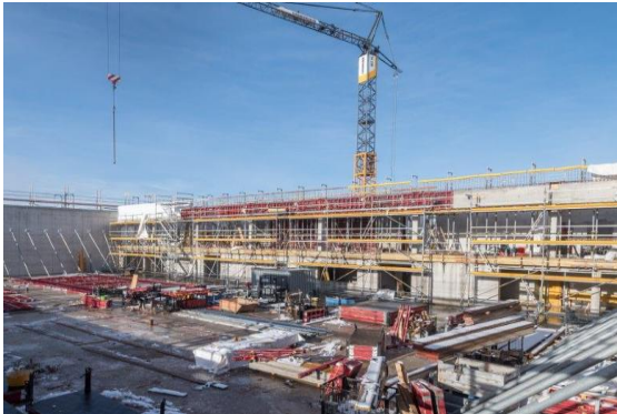
Neubau der Sporthalle in der General-Fellgiebel-Kaserne in Pöcking (Juli 2018) |
